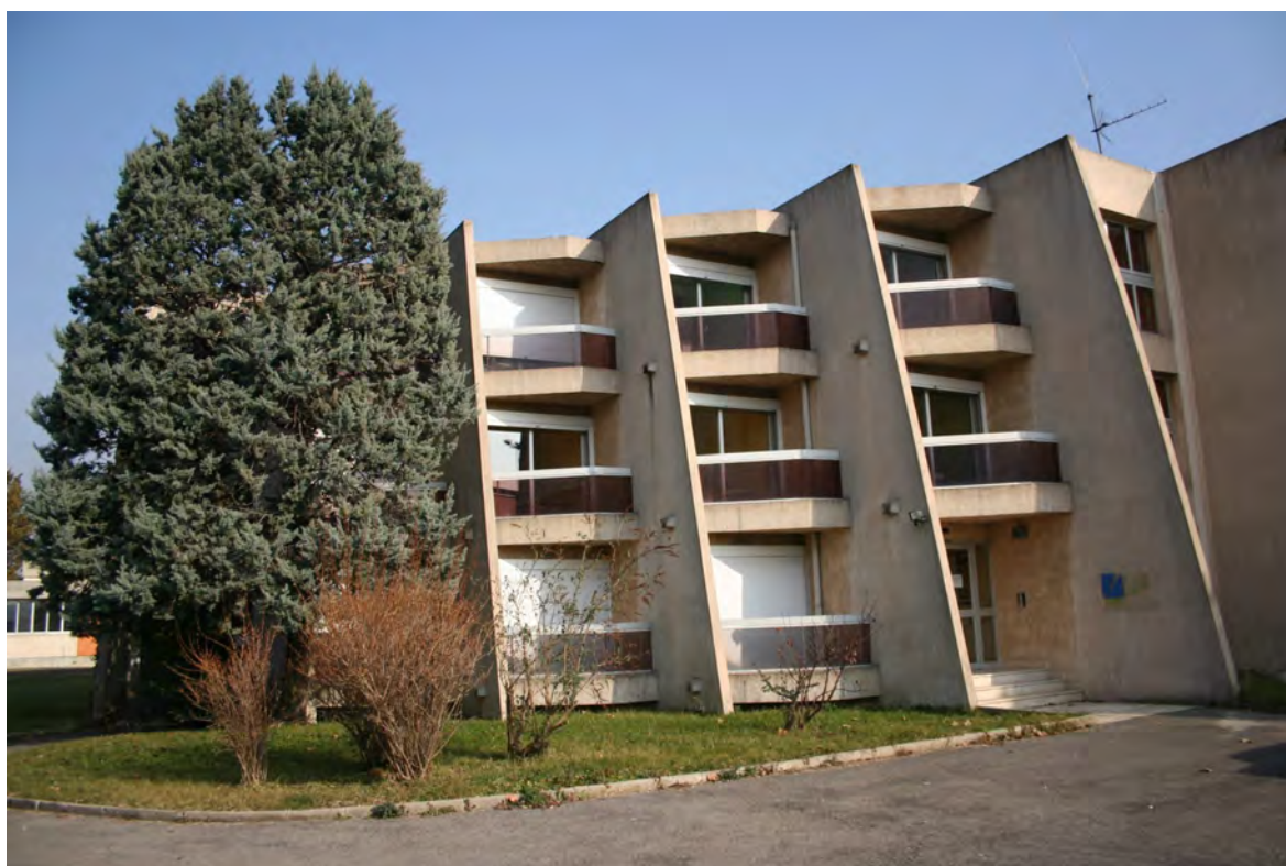
Bâtiment pour l'hébergement des stagiaires, CVRH d'Aix-en-Provence
