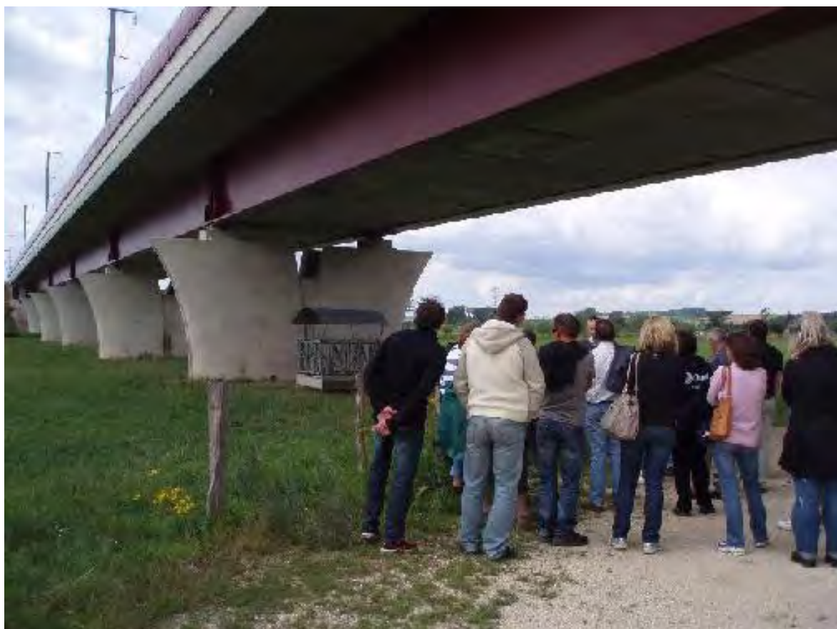
Formation sur la prise en compte de la biodiversité sur un chantier de LGV, CVRH de Nancy
