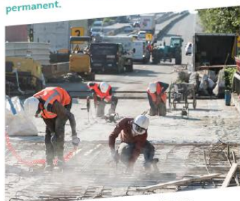
Rénovation du pont de l'A6 sur l'Esnonne à Ormoy.
